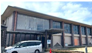
体育館・作業実習棟
